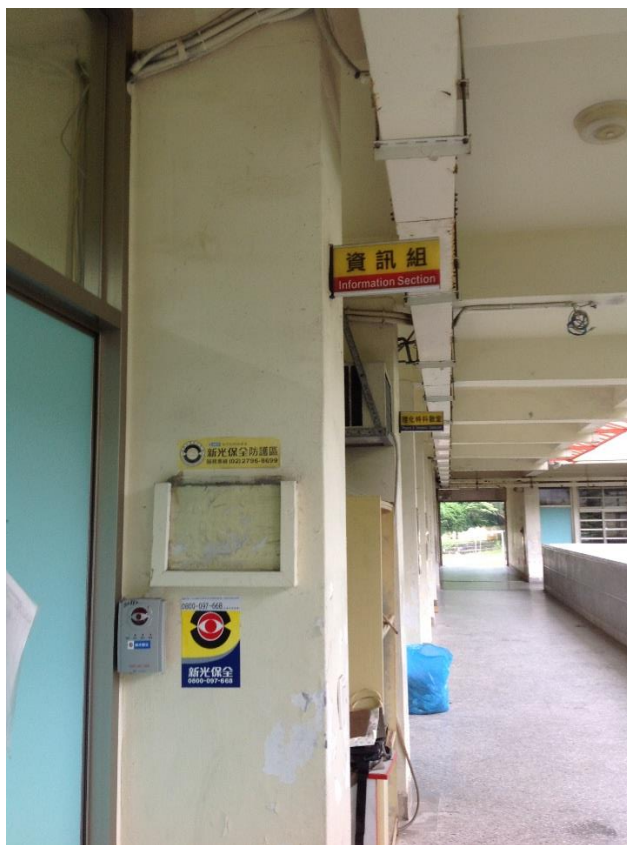
資訊組機房除門鎖之外還有保全
