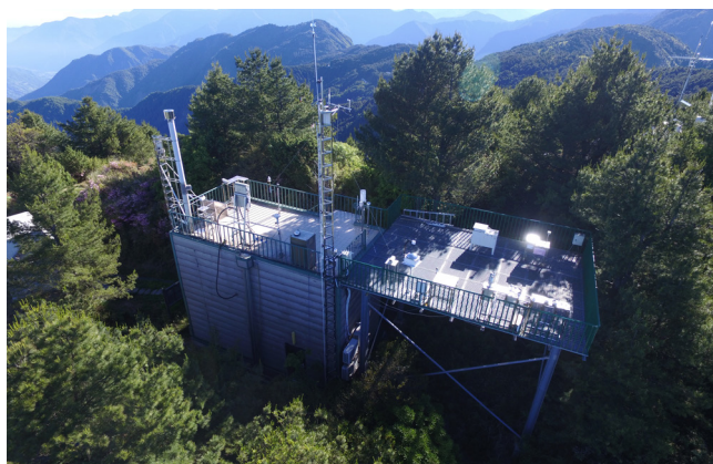
▲ 鹿林山國際大氣背景監測站。
