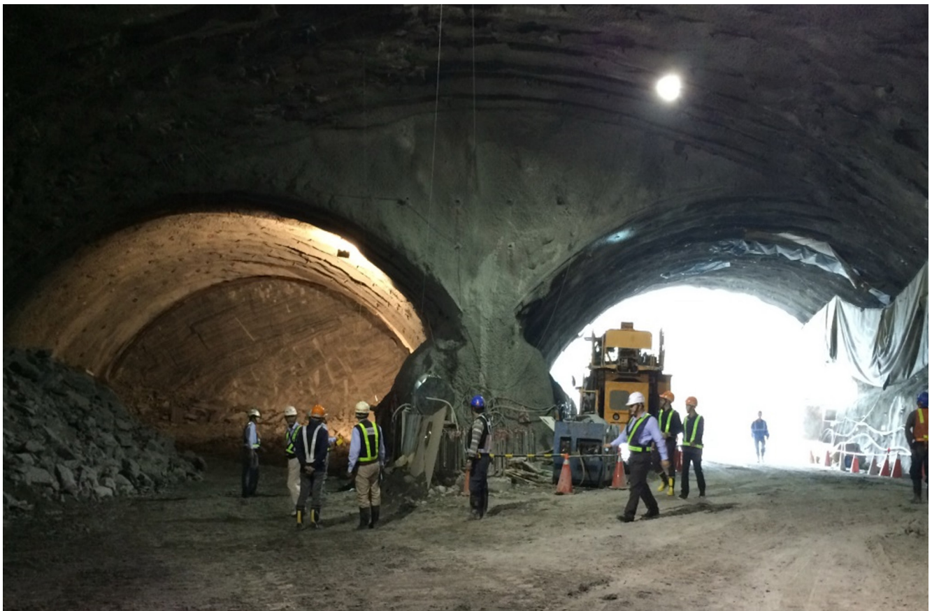
▲ 曾文水庫防淤隧道香菇頭工法施工。
