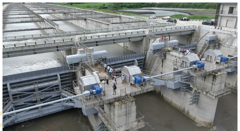
▲ 阿姆坪防淤隧道沖淤池弧型閘門為目前國內最寬且唯一用來擋泥水壓力的閘門。
